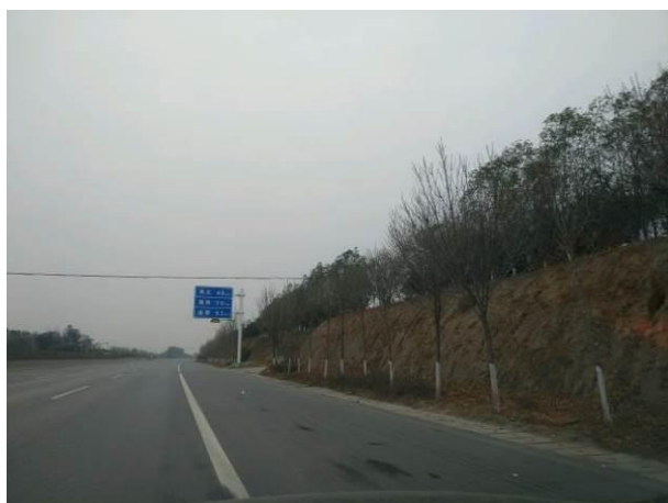
挖方段--路基两侧绿化
