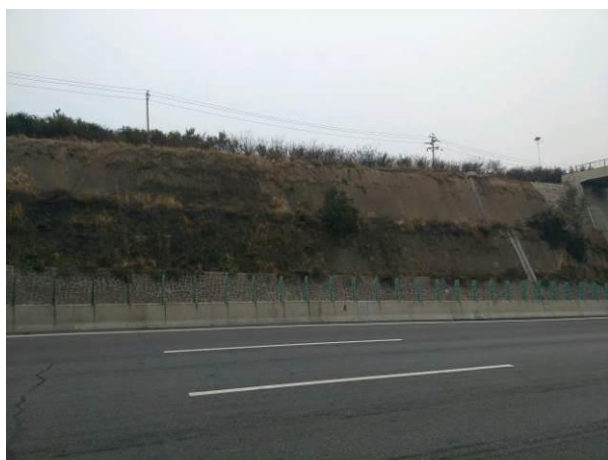
巩义境内—深挖段路基防护
