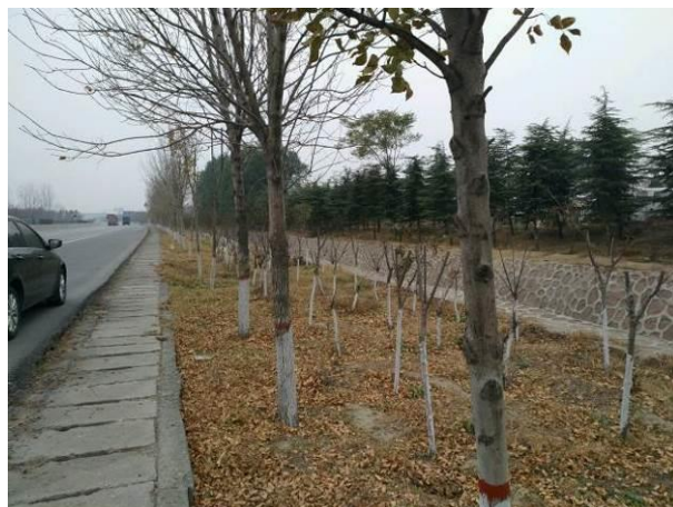
K85 处路基两侧绿化及排水
