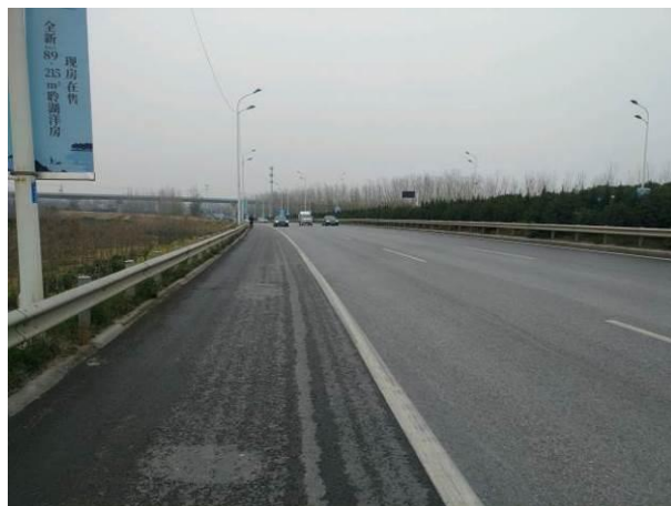
下穿京广铁路和郑焦城际铁路处西侧
