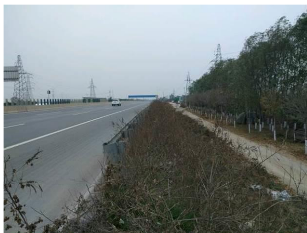
K69 张河村处—路基边坡防护
