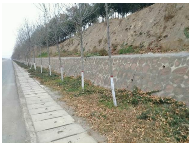
挖方段--路基两侧排水、绿化
