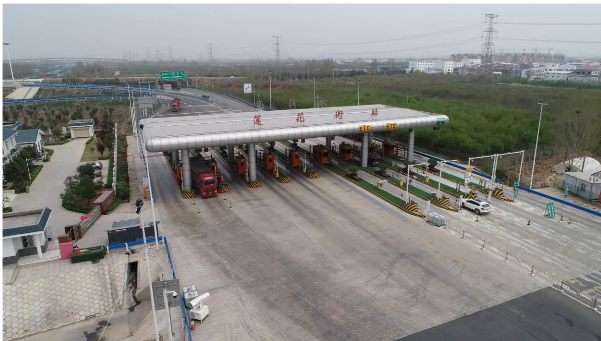
收费站处—现场影像
