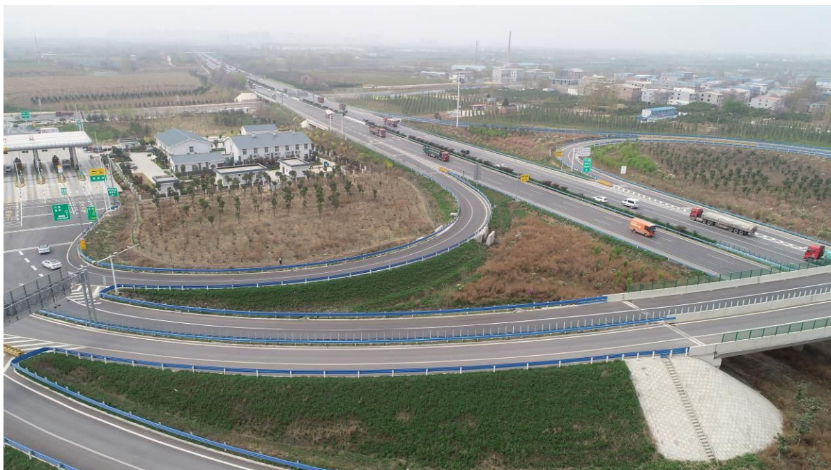
互通区匝道边坡绿化防护情况
