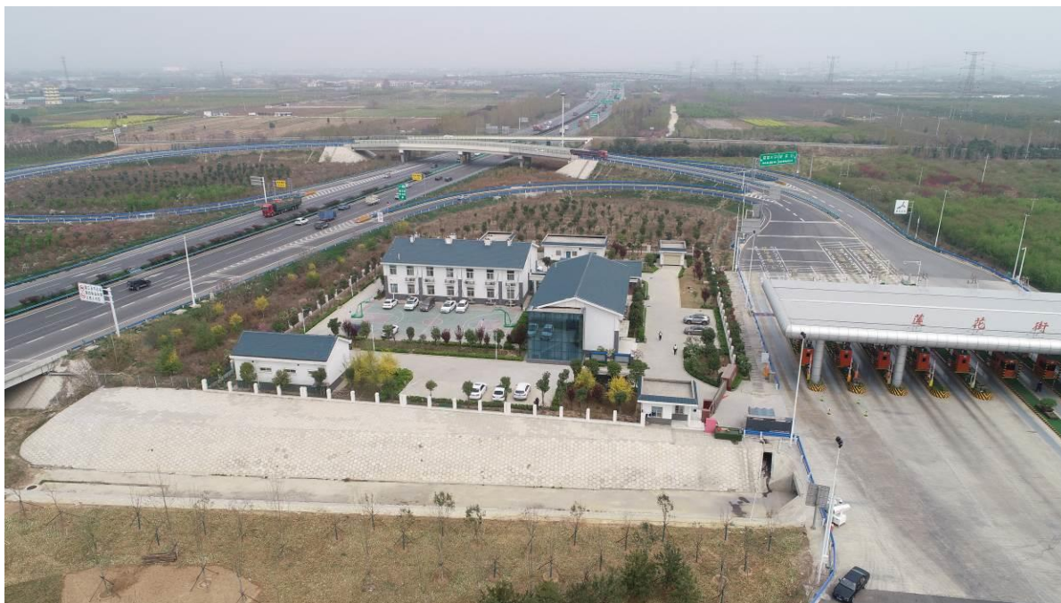
管理设施区—水保措施实施情况
