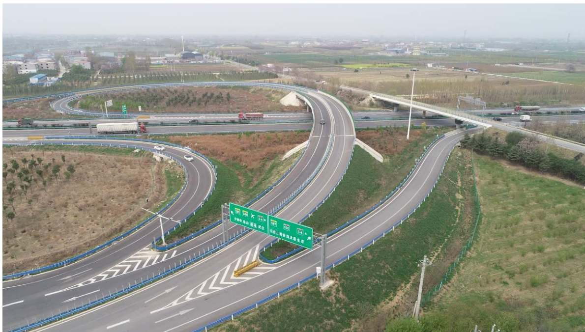
互通区匝道边坡绿化防护情况
