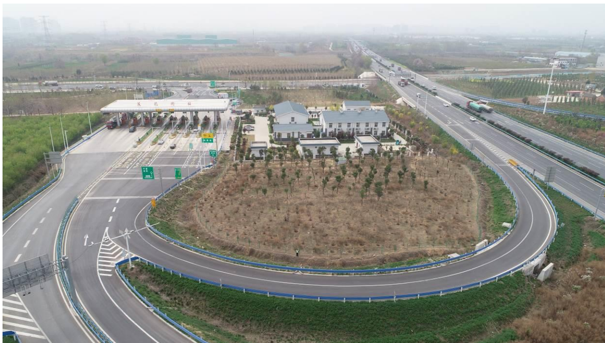
互通区匝道边坡绿化防护情况
