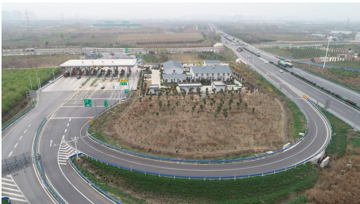
互通区匝道边坡绿化防护情况
