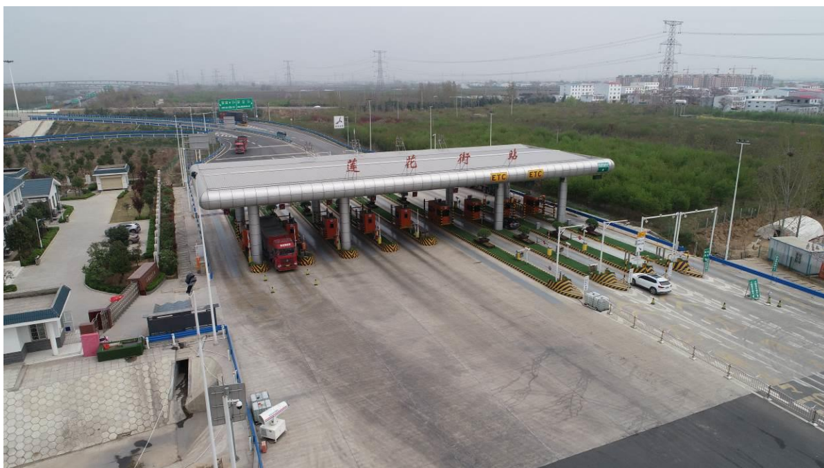
收费站处—现场影像
