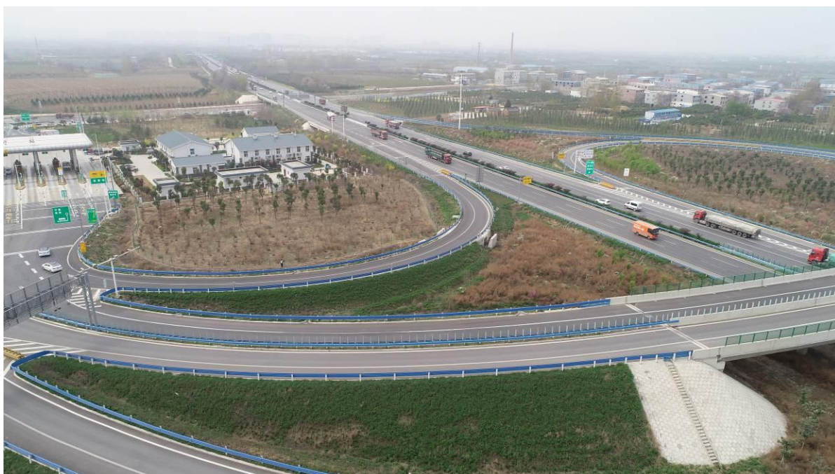
互通区匝道边坡绿化防护情况
