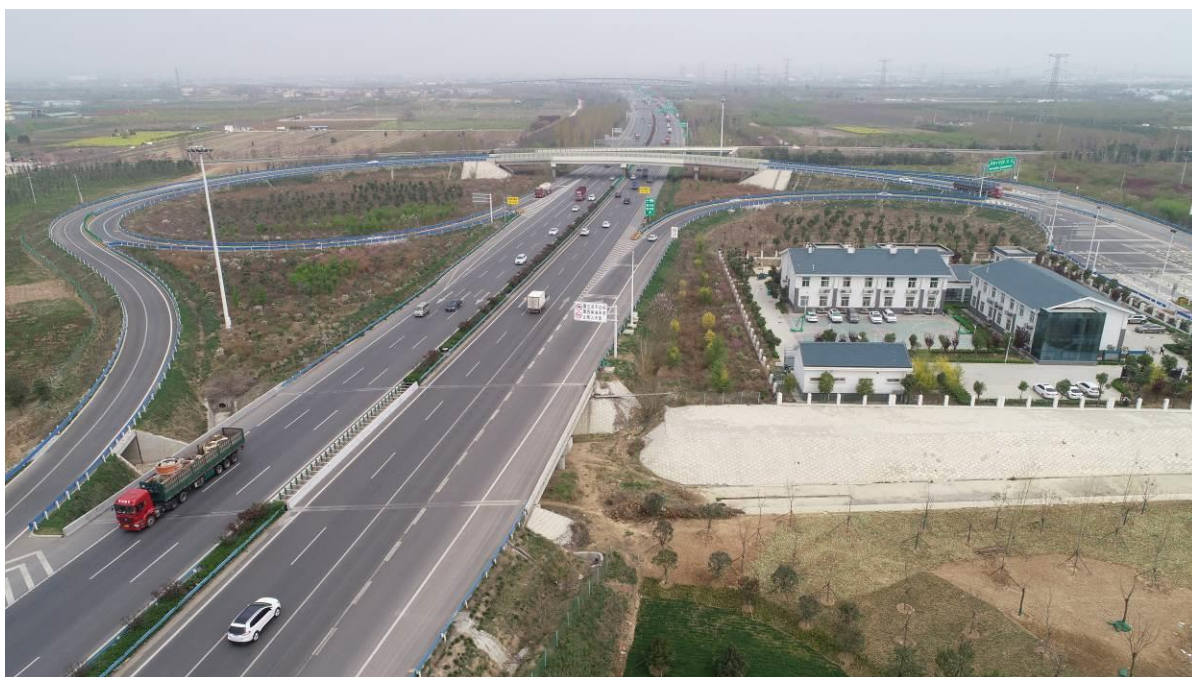
西南绕城高速主线情况
