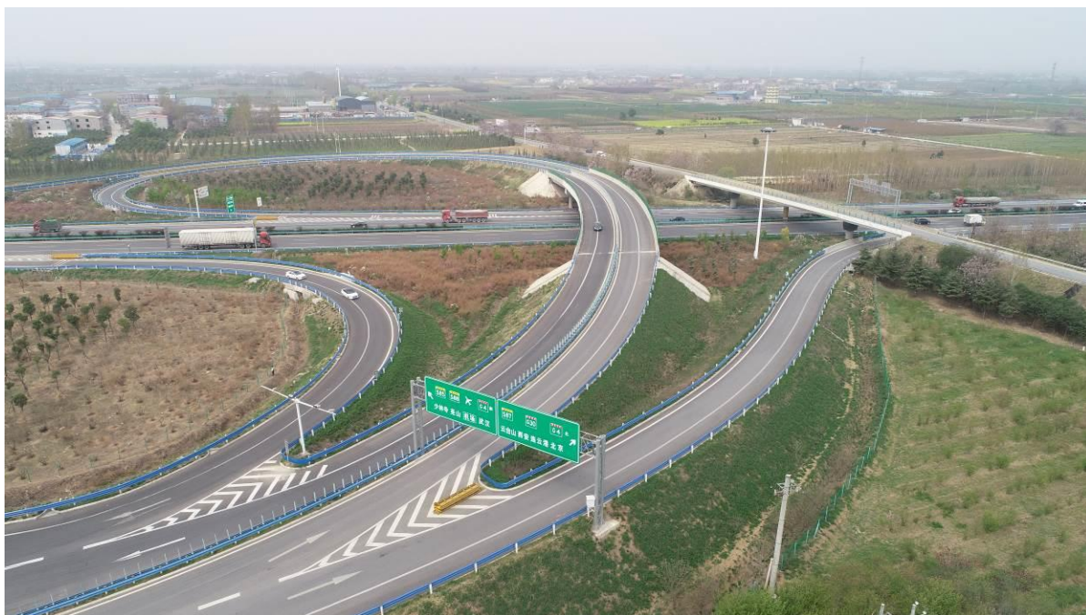
互通区匝道边坡绿化防护情况
