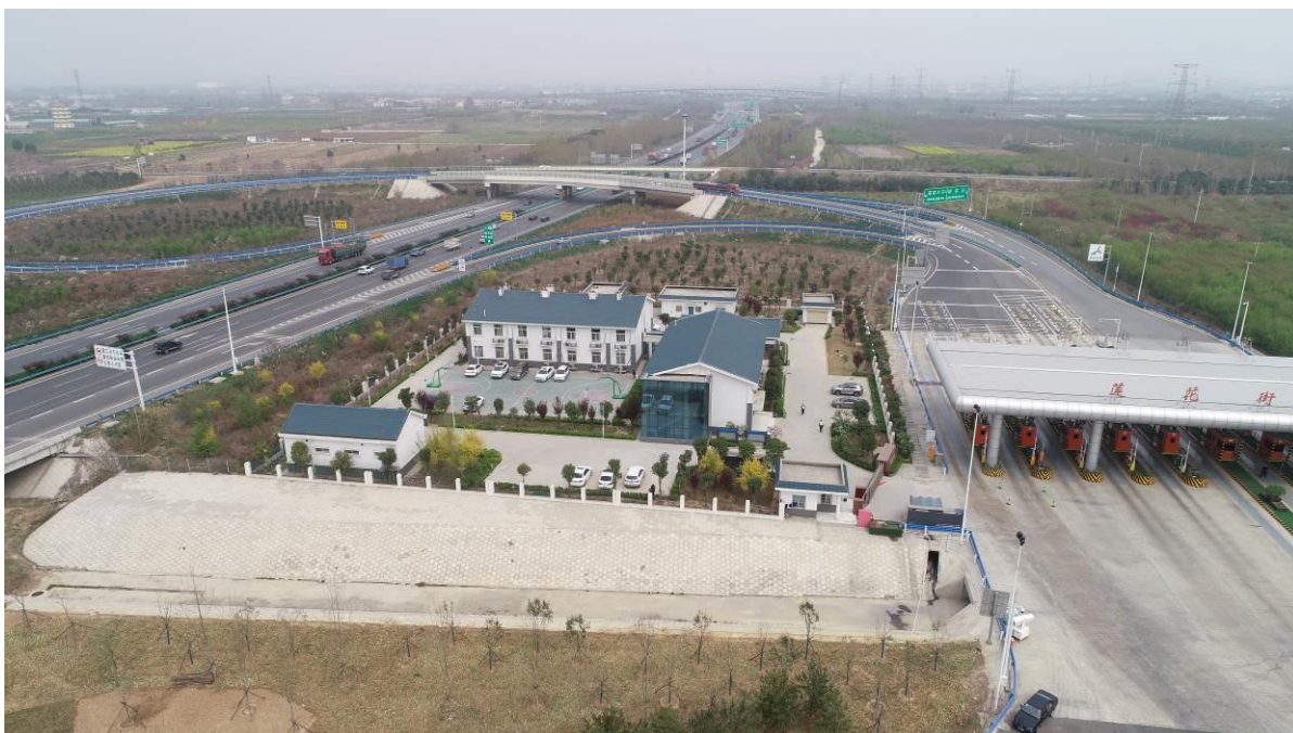
管理设施区—水土保持措施实施情况
