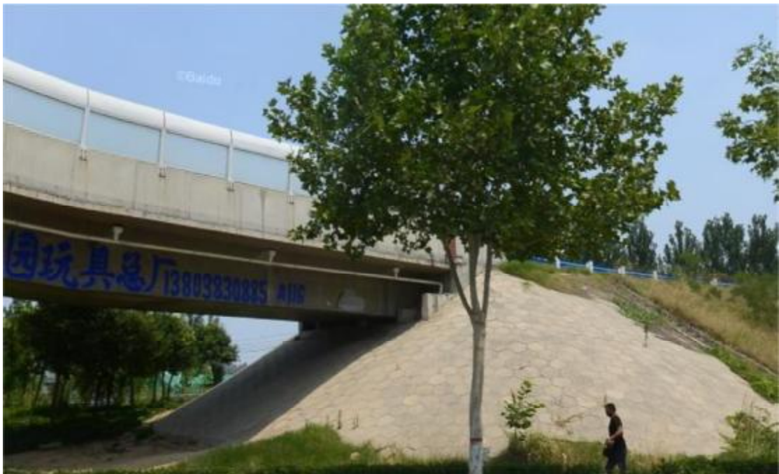
桥梁斜坡防护工程
