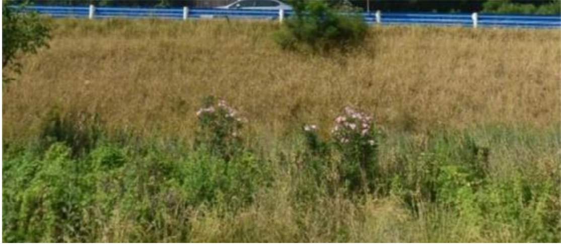
路基斜坡防护工程
